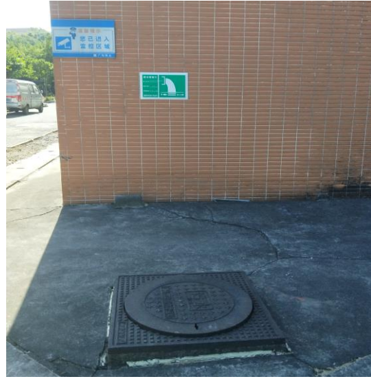
第二冷站污水排放口（远景）
