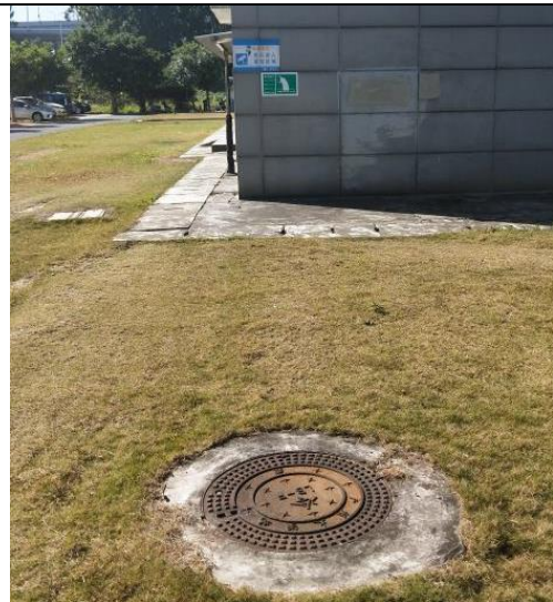
第四冷站污水排放口（远景）
