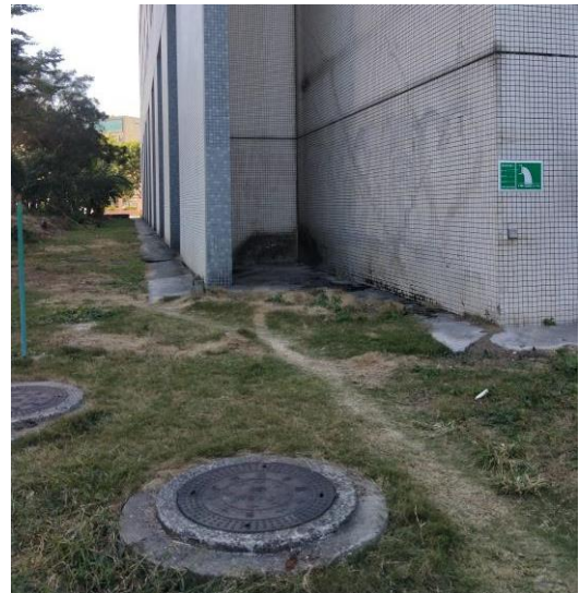
第三冷站污水排放口（远景）
